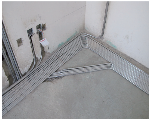
图2-8 镀锌钢管地面施工图例
