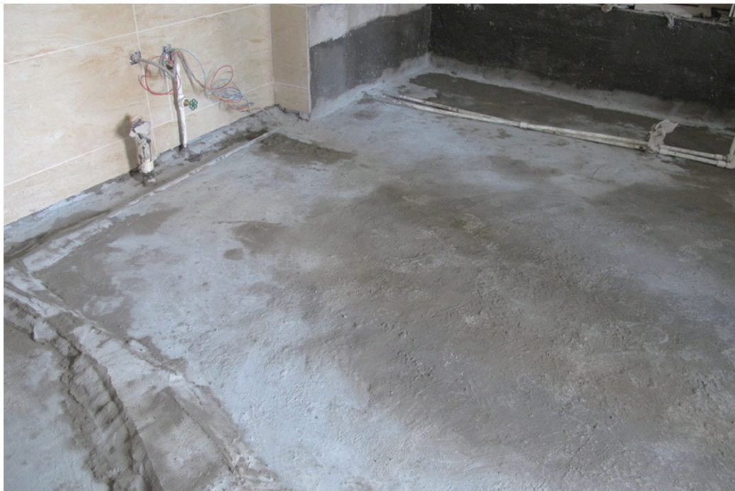
图2-13 注水后即可进行闭水试验
