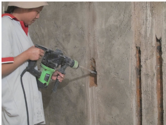
图2-4 墙面开槽
