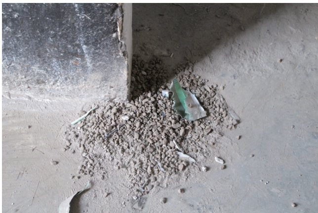
图2-11 清理施工现场杂物
