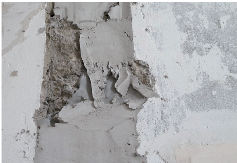
图2-10 墙体破坏较严重时用水泥砂浆进行填补
