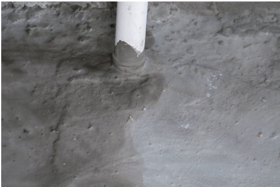
图2-12 管根部位防水处理
