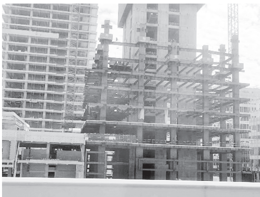
图 1-4 钢框架—核心筒体系
