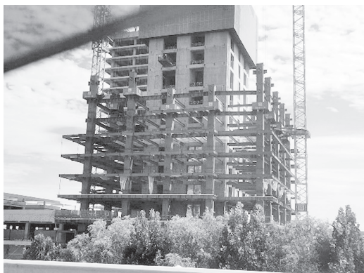
图 1-4 钢框架—核心筒体系
