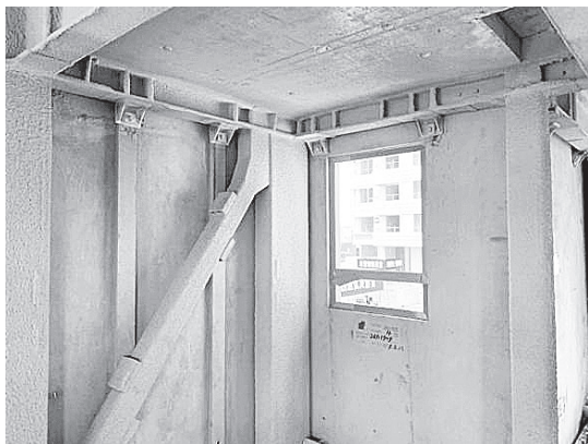
图 1-3 远大节点斜撑加强型钢框架体系
