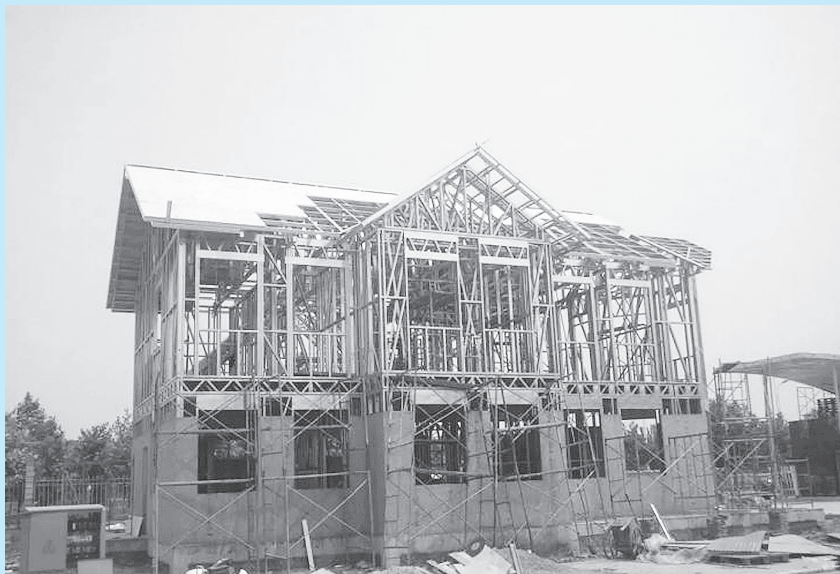
图 1-1 冷弯薄壁轻钢结构
