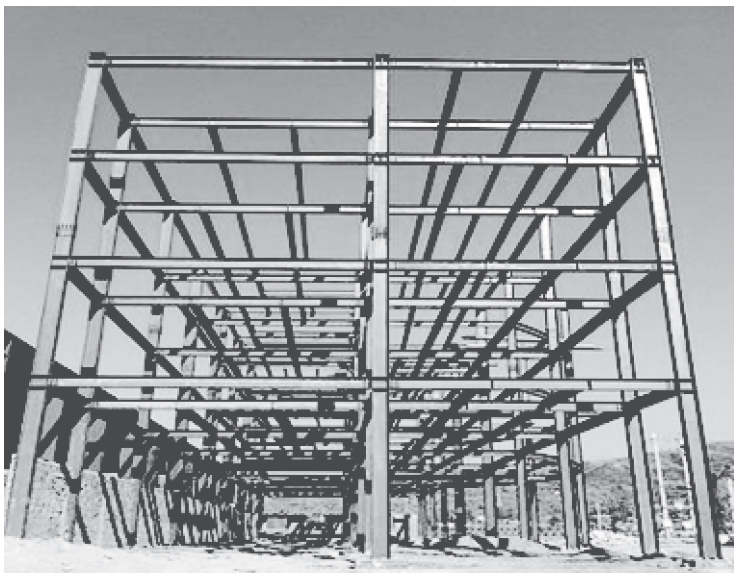
图 1-2 型钢梁柱框架结构
