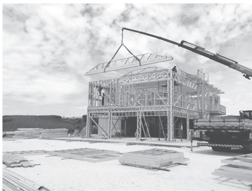
图 1-6 装配式钢结构建筑
