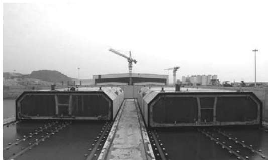
图 1.3.2 港珠澳大桥海底隧道沉管
