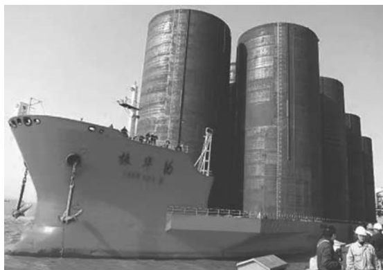
图 1.3.1 港珠澳大桥人工岛围护钢圆筒
