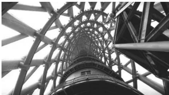
图 1.8.3 广州塔格栅开放式结构
