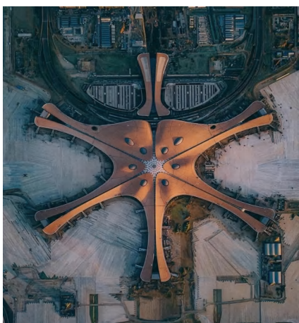
图 1-35 北京大兴国际机场
